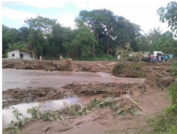
Acumulación de materiales de arrastre
