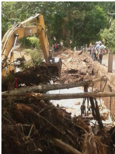
Trabajos previos de limpieza
